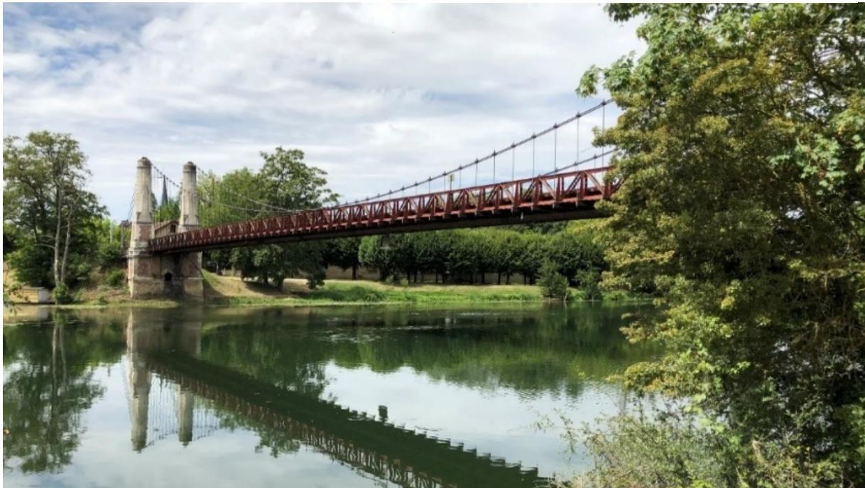
Un pont suspendu à câbles porteurs, le tablier est suspendu à des câbles porteurs prenant appui sur des pylônes et ancrés dans la terre à chaque extrémité du pont. © Djamel Ferrand – DGSCGC
