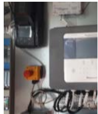
Bouton présent dans le local électrique permettant l'arrêt du process gaz. © Source GRDF
