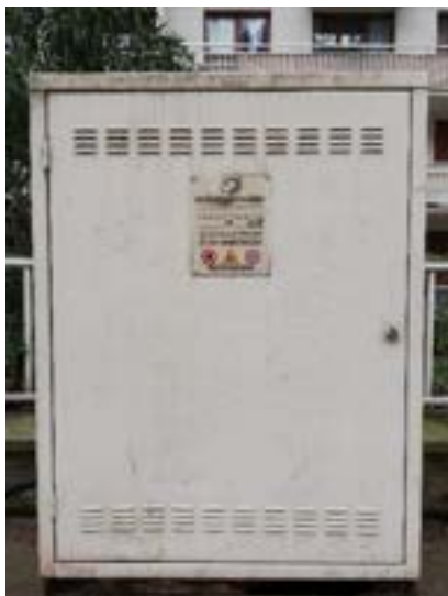
Poste GRDF de livraison gaz RESEAU , les sapeurs-pompiers ne peuvent pas couper le gaz, il n'y a pas d'organe de coupure générale. © Christophe Perdriset – DGSCGC
