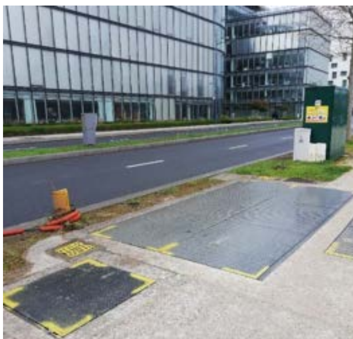
Poste enterré à Issy-les-Moulineaux © Christophe Perdrisot – DGSCGC
