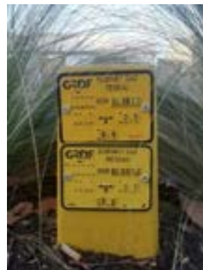
Borne signalant la présence d'un robinet gaz du réseau GRDF © Christophe Perdrisot – DGSCGC
