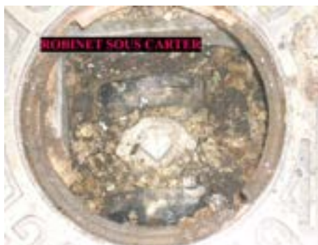
Organe de coupure générale sous carter © GRDF
