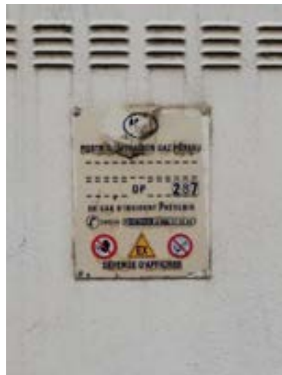
Poste GRDF de livraison gaz RESEAU , les sapeurs-pompiers ne peuvent pas couper le gaz, il n'y a pas d'organe de coupure générale. © Christophe Perdriset – DGSCGC
