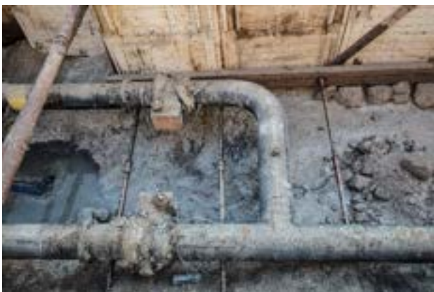
Canalisations sous-marines à Marseille© GRDF
