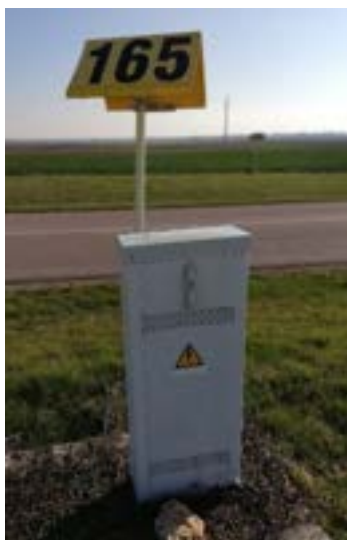
Borne de mesure de protection cathodique © Christophe Perdrisot – DGSCGC
