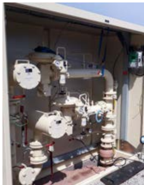
Canalisation à périmètre de sécurité étendu et poste de détente réseau MPC/MPB © GRDF
